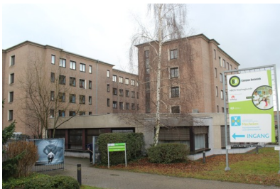
Campus Botaniek krijgt nieuwe verwarmingsketels. FOTO STIJN VAN DE SANDT
